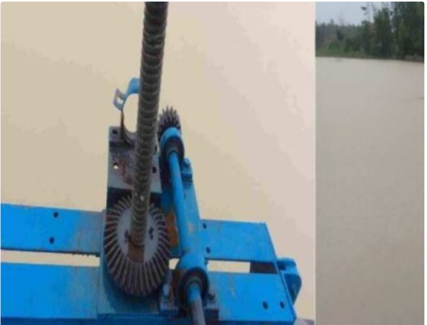
Pintu air Albaret Simpang Mesuji
