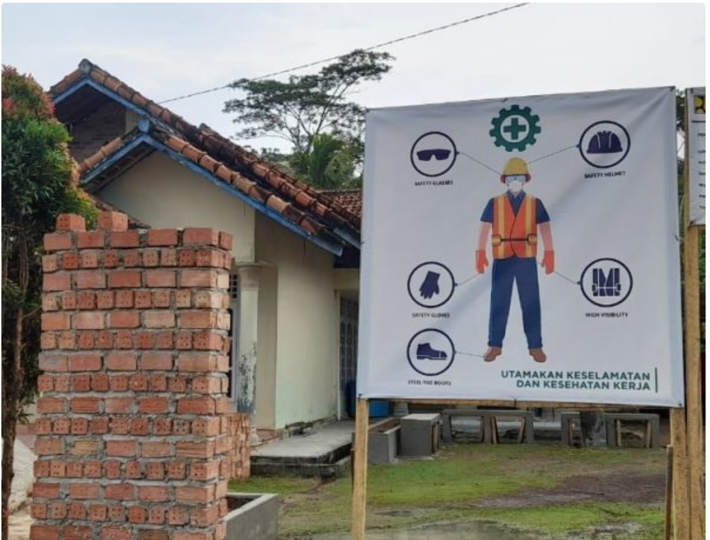
Proyek Infrastruktur Hunian Hijau di Mesuji
